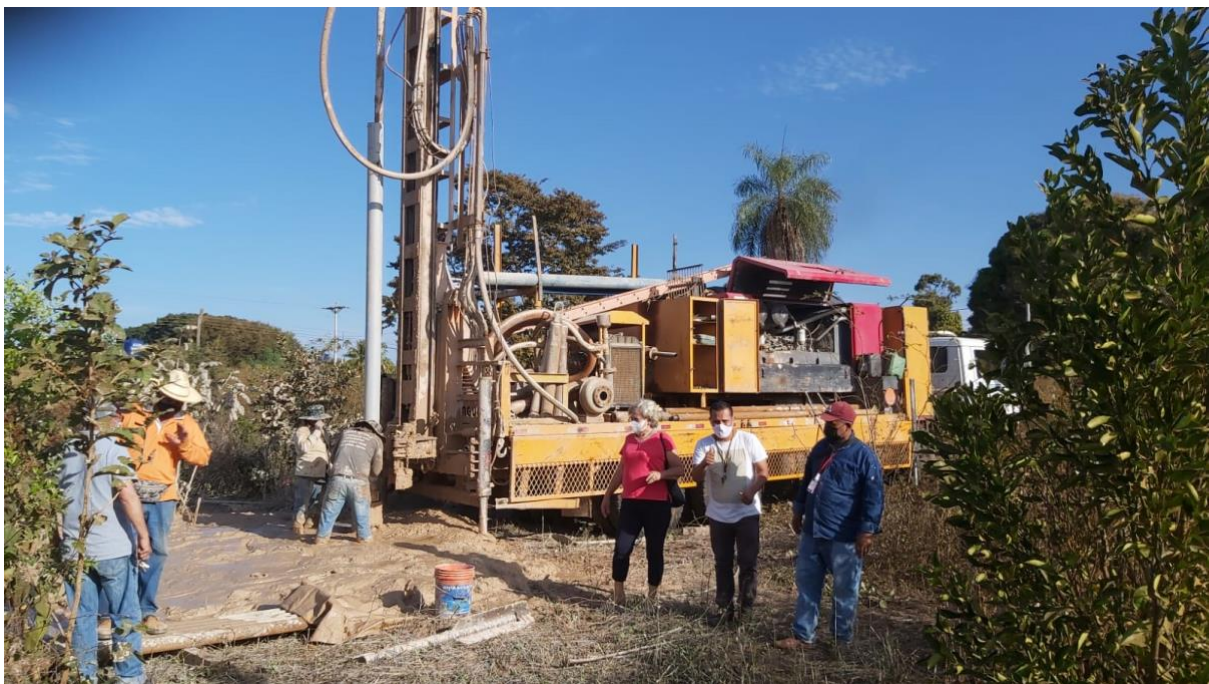
Wasser ist ein knappes Gut! Hier wird ein Brunnen gegraben, damit die neu angelegten Gemüsegärten mit Wasser versorgt sind. Das Wasser sprudelt bereits!
